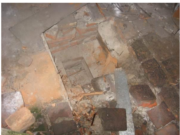
Sondy do stropní konstrukce 2.NP v půdním prostoru
