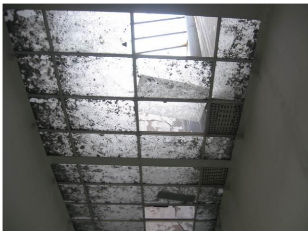
Poškozený světlik za schodišťovým prostorem ve 2.NP. Do stropní konstrukce 1.NP zatéká při dešti.
