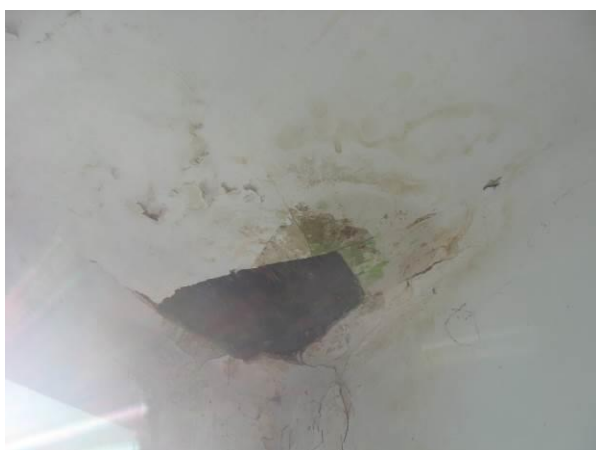
Negativní vliv zatékání do konstrukce stropu a stěn při dešti v 2. a 1. nadzemním podlaží. Vliv poškozené střešní krytiny.
