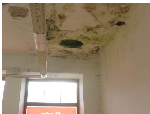
Negativní vliv zatékání do konstrukce stropu a stěn při dešti v 2. a 1. nadzemním podlaží. Vliv poškozené střešní krytiny.
