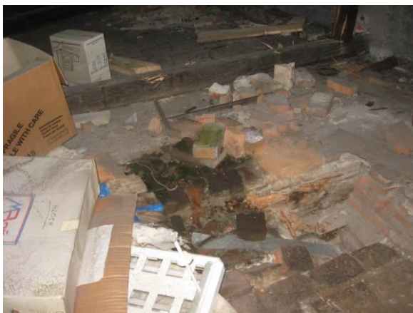
Sondy do stropní konstrukce 2.NP v půdním prostoru
