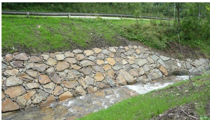
Obr.: vzorový příklad rovnaniny – opevnění v toku
