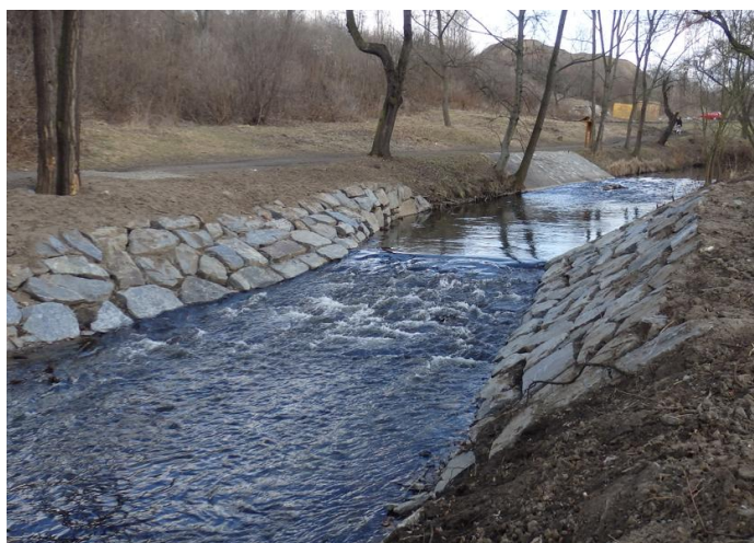
Obr. Příklad balvanitého skluzu
