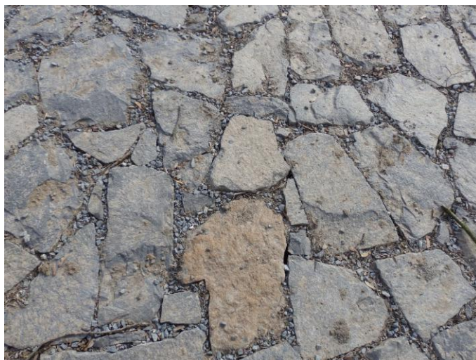
Obr.: vzorový příklad rovnaniny s urovnáním líce - brod
