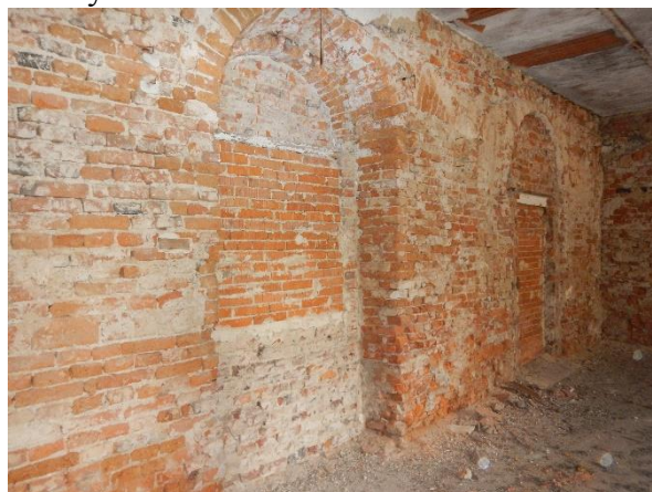
Foto č. 35 - 38 – narušení cihelného zdiva z důvodu vysoké vlhkosti
