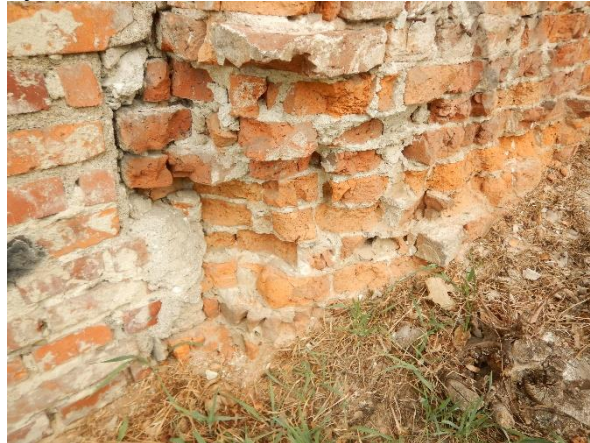
Foto č. 47 a 48 – odtržení přístavby od objektu, vydrolování cihel. zdiva
