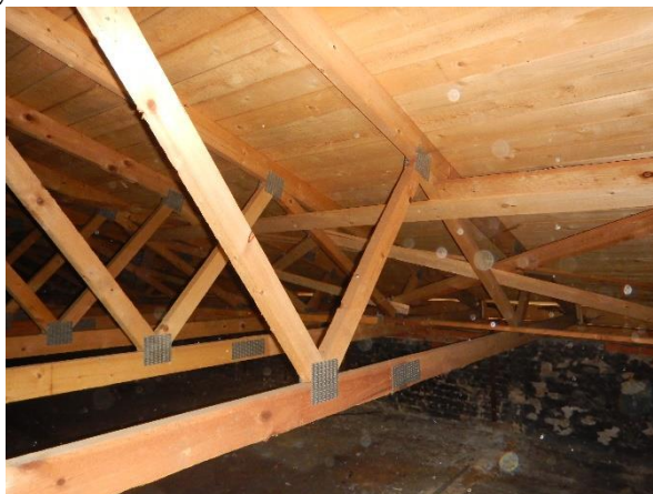
Foto č. 9 - 14 – krov - celkové pohledy a detaily nové střešní konstrukce
