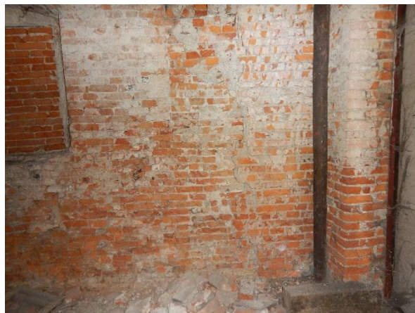
Foto č. 35 - 38 – narušení cihelného zdiva z důvodu vysoké vlhkosti
