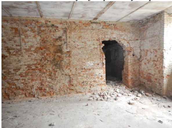
Foto č. 31 a 32 – vybouraný otvor ve vnitřní nosné stěně
