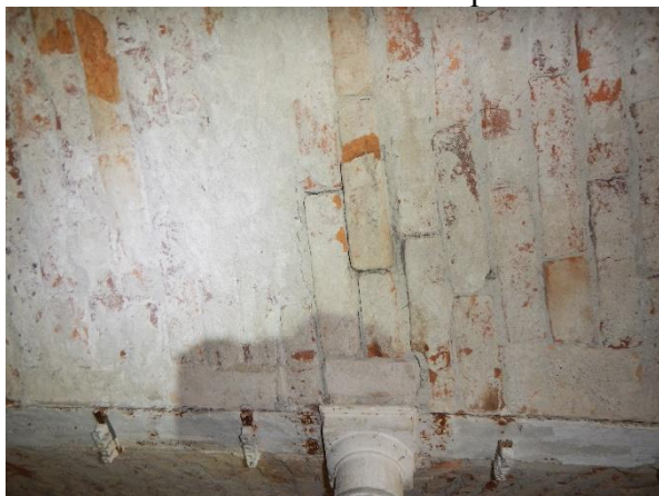
Foto č. 15 a 16 – rozvolněná a opadaná lokalita v cihelné klenbě
