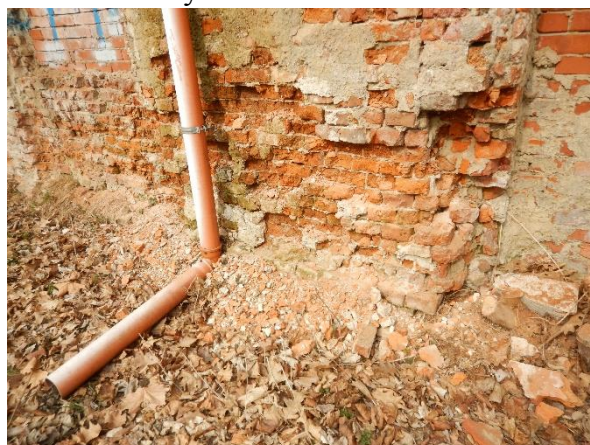
Foto č. 53 - 55 – severovýchodní pohled, výrazné trhliny ve zdivu
