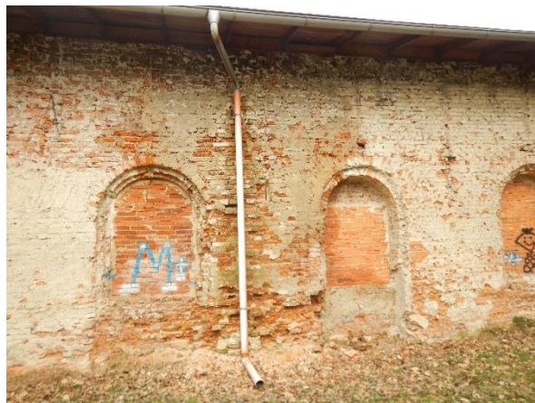
Foto č. 52 – vydrolování cihel zdiva
