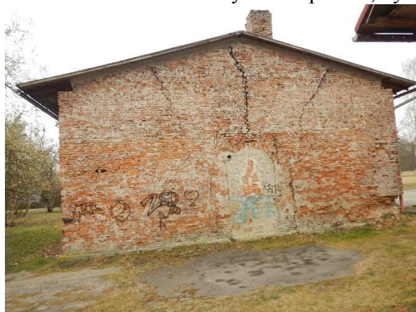
Foto č. 53 - 55 – severovýchodní pohled, výrazné trhliny ve zdivu
