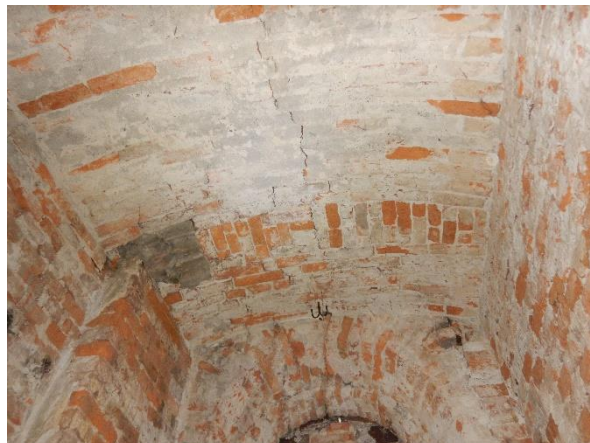
Foto č. 21 - 22 – rozpraskané a opadané stropní Hurdis desky
