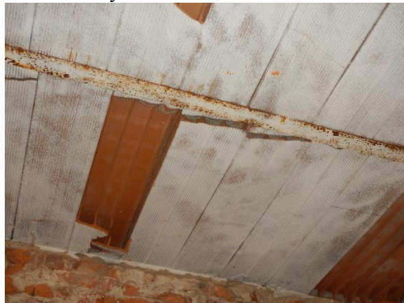
Foto č. 24 – neuložený I nosník (odstr. překl.)
