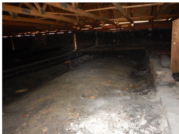
Foto č. 29 - 30 – chybějící překlady a opadávání zdiva
