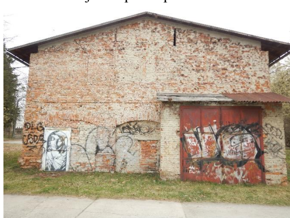
Foto č. 47 a 48 – odtržení přístavby od objektu, vydrolování cihel. zdiva
