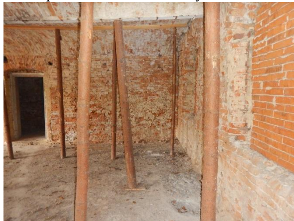
Foto č. 17 - 18 – provizorní podepření klenbových stropů v hlavní části budovy
