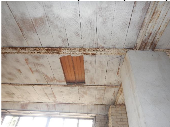
Foto č. 23 – zborcená stropní konstrukce
