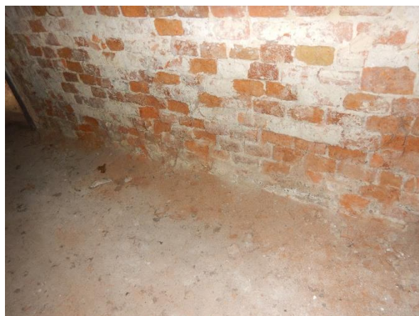
Foto č. 39 a 40 – velmi silná koroze I pod místnosti ve snižené části objektu, pohled zespod
