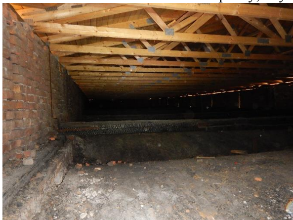
Foto č. 25 - 27 – ohořelé dřevěné prvky, chybějící podlaha nad klenbovým stropem
