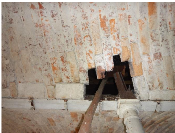
Foto č. 15 a 16 – rozvolněná a opadaná lokalita v cihelné klenbě
