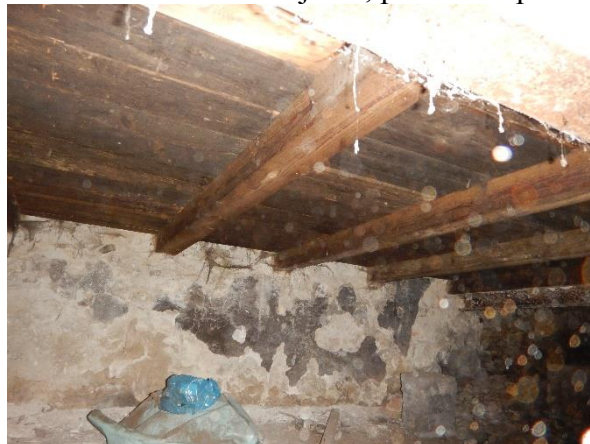
Foto č. 39 a 40 – velmi silná koroze I pod místnosti ve snižené části objektu, pohled zespod
