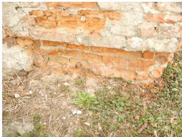
Foto č. 47 a 48 – odtržení přístavby od objektu, vydrolování cihel. zdiva
