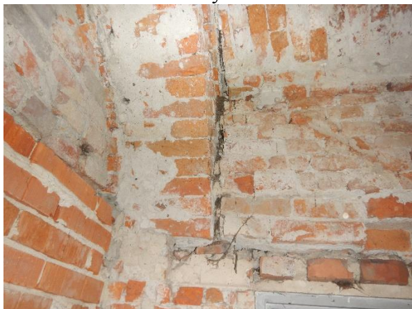
Foto č. 35 - 38 – narušení cihelného zdiva z důvodu vysoké vlhkosti
