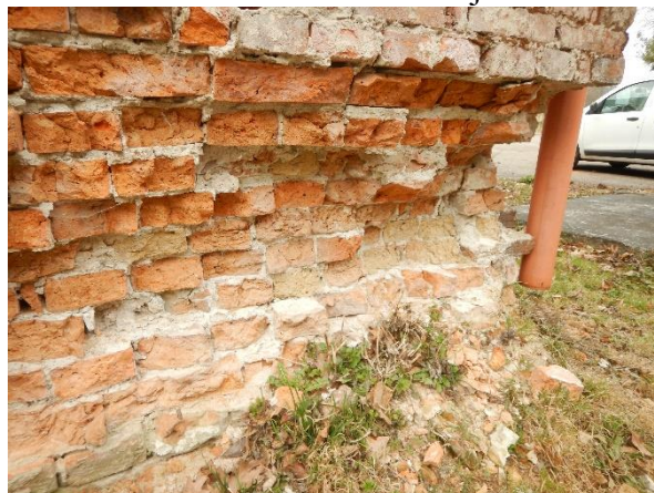
Foto č. 44 a 45 – vydrolování cihel. zdiva
