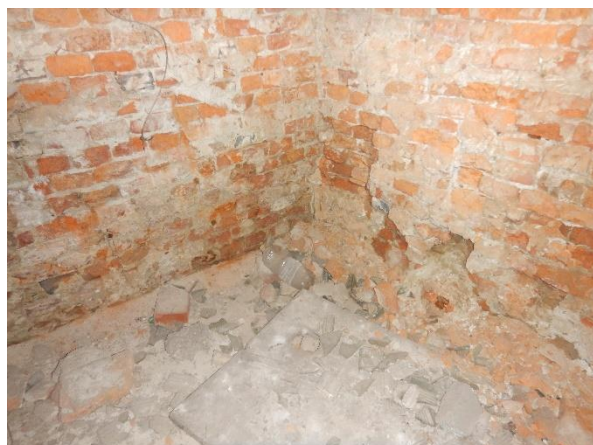
Foto č. 35 - 38 – narušení cihelného zdiva z důvodu vysoké vlhkosti
