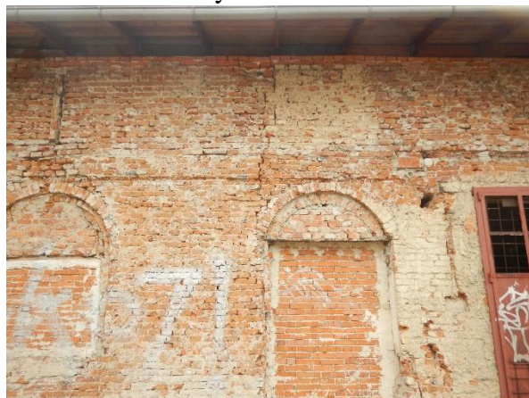
Foto č. 43 – trhliny ve zdivu
