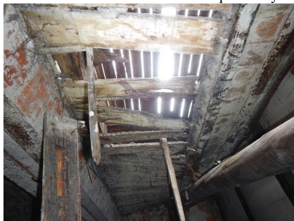
Foto č. 28 – destrukce zastřešení přístavby
