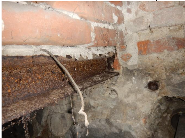
Foto č. 39 a 40 – velmi silná koroze I pod místnosti ve snižené části objektu, pohled zespod
