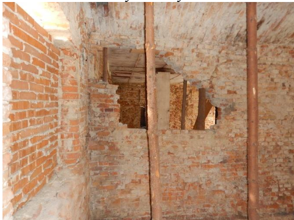
Foto č. 31 a 32 – vybouraný otvor ve vnitřní nosné stěně
