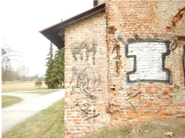
Foto č. 47 a 48 – odtržení přístavby od objektu, vydrolování cihel. zdiva
