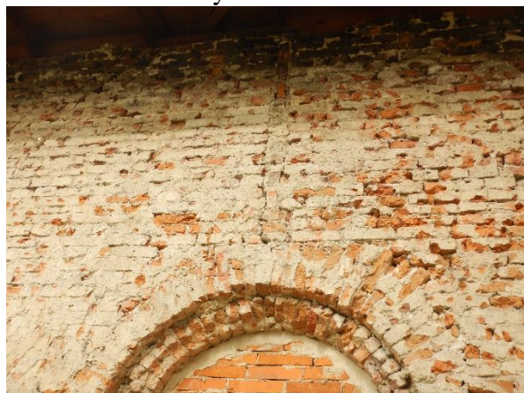
Foto č. 53 - 55 – severovýchodní pohled, výrazné trhliny ve zdivu
