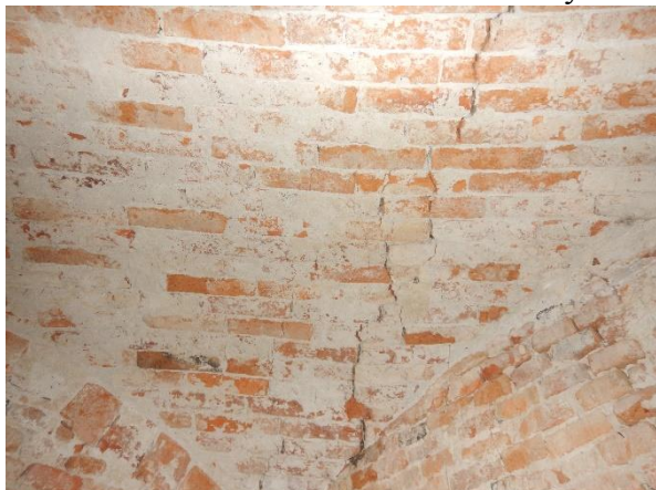
Foto č. 21 - 22 – rozpraskané a opadané stropní Hurdis desky
