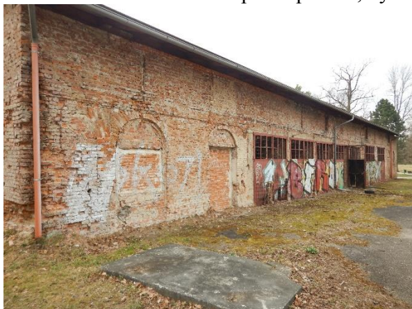
Foto č. 43 – trhliny ve zdivu
