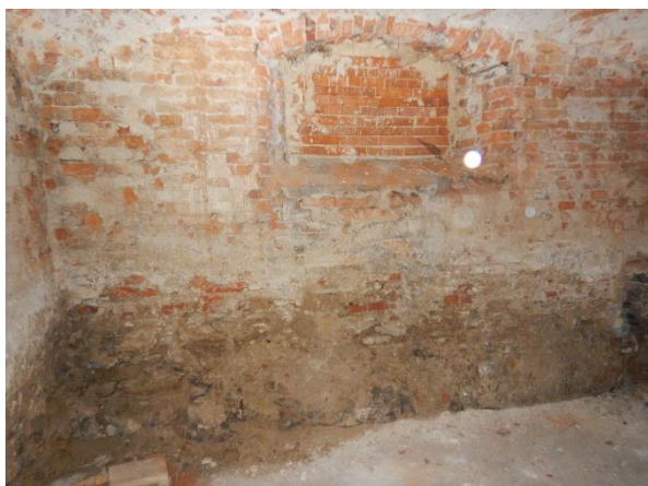
Foto č. 39 a 40 – velmi silná koroze I pod místnosti ve snižené části objektu, pohled zespod
