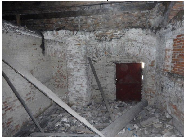
Foto č. 23 – zborcená stropní konstrukce
