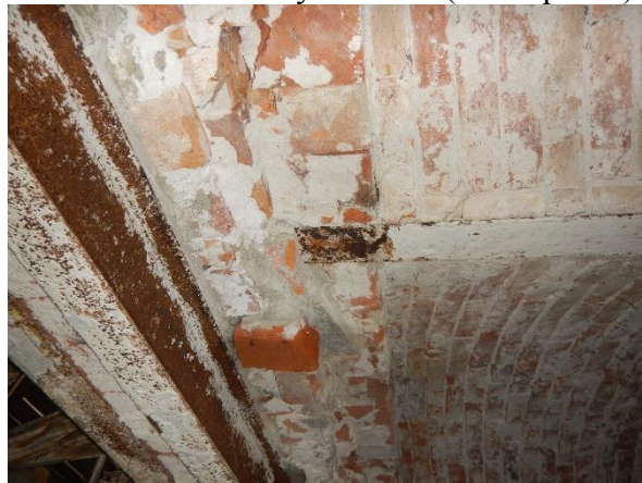
Foto č. 24 – neuložený I nosník (odstr. překl.)
