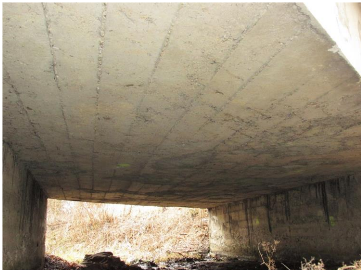
Podhled nosné konstrukce zprava.
