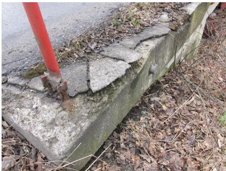
Nivelační značka na římse vpravo před OP1, detail ukotvení zábradlí.
