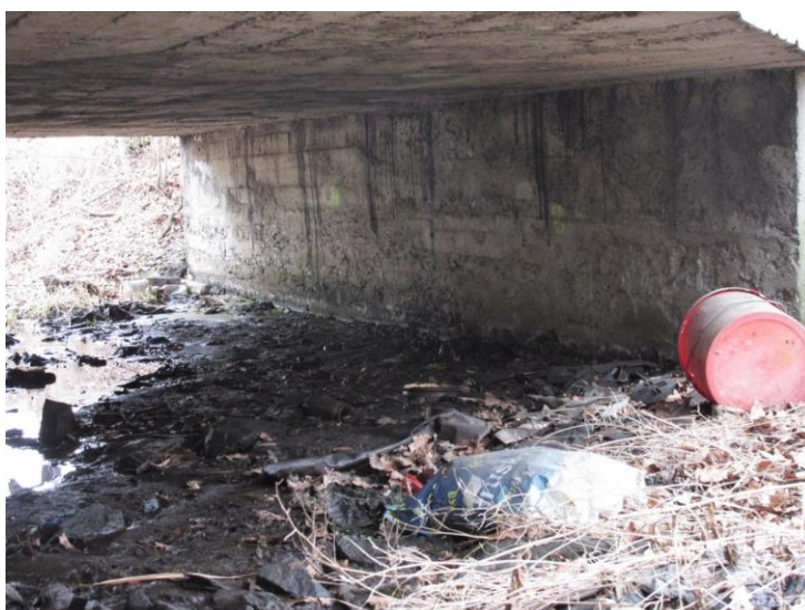
Pohled na opěru OP2.
