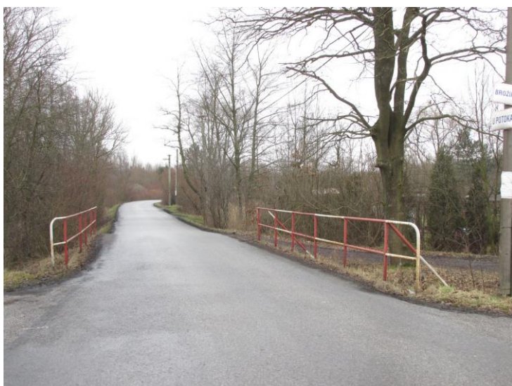
Pohled na most proti směru orientace záznamu.
