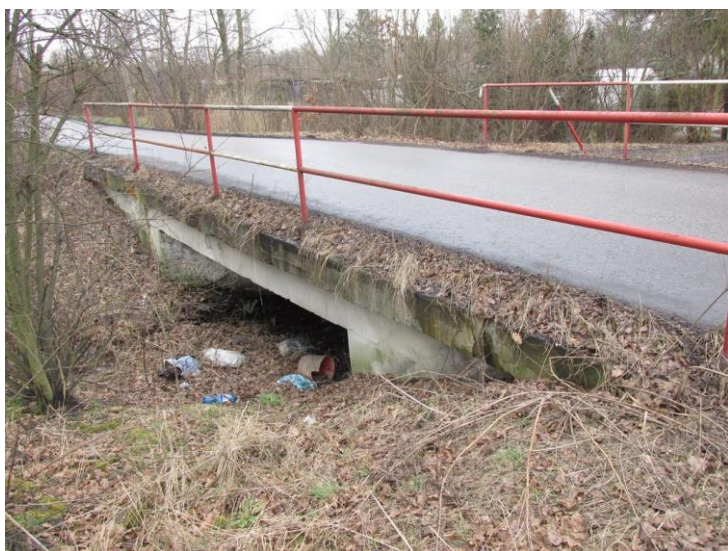
Pohled na most zprava.
