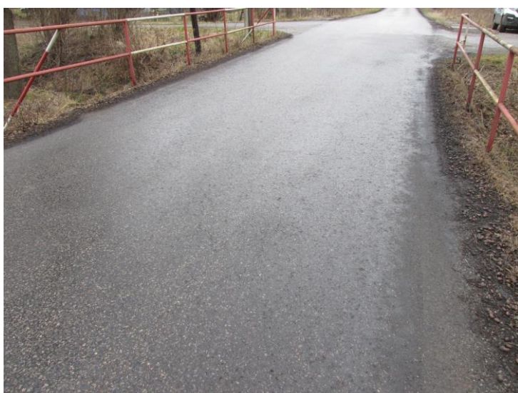
Pohled na vozovku na mostě.
