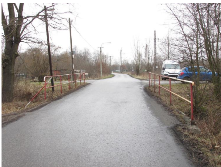
Pohled na most ve směru orientace záznamu.
