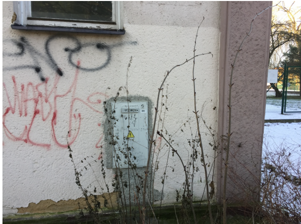
Pojistková skříň SS101, ČEZ Distribuce, a.s. na severozápadní fasádě
