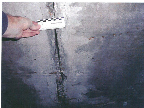
I takto je odhalená nosná výztuž v některých místech, zejm. okrajových partiích podhledu mostovky.
