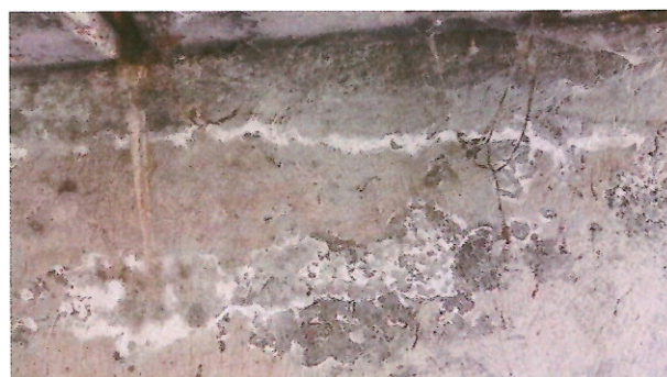
Obr. 3: Opěra č. 1 – zatékání do konstrukce přes nosnou konstrukci.
