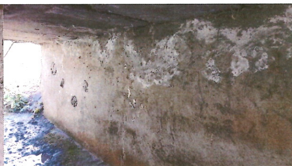
Obr. 4: Opěra č. 1 – zatékání do konstrukce přes nosnou konstrukci.
