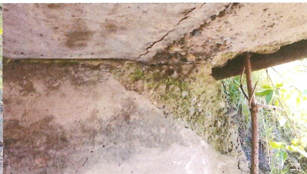
Obr. 2: Opěra č. 1 – rozpad struktury betonu v důsledku zatékání vody a působení mrazu.
