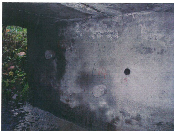
Vývrty V3 a V4, provedené do levobřežní opěry.
