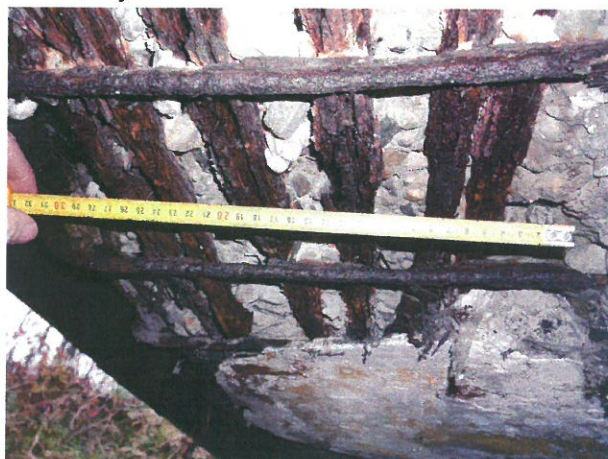
Rozpad výztuže římsy na podhledu – situace na povodní straně mostu.
