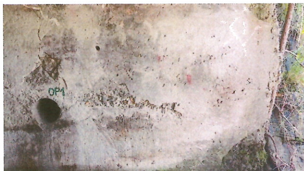
Obr. 1: Opěra č. 1 – odpadnutá ochranná vrstva CM, obnažená struktura betonu.
