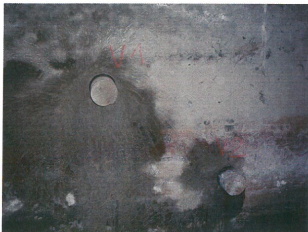
Vývrty V1 a V2, provedené do pravobřežní opěry.
