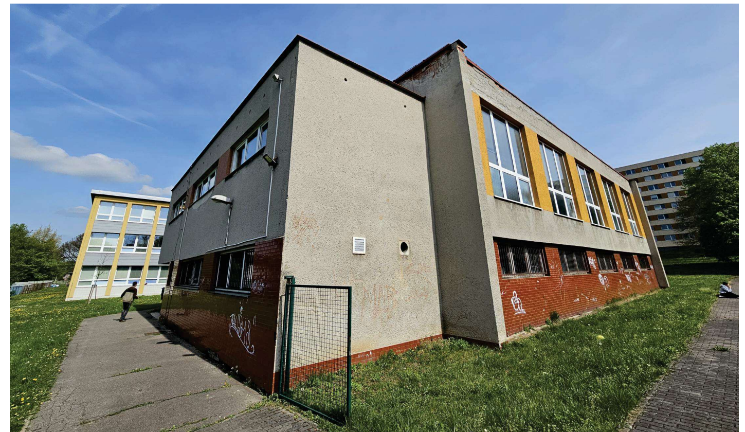
Pohled na boční fasádu objektu
