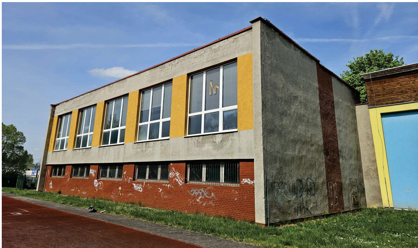
Pohled na čelní fasádu objektu
