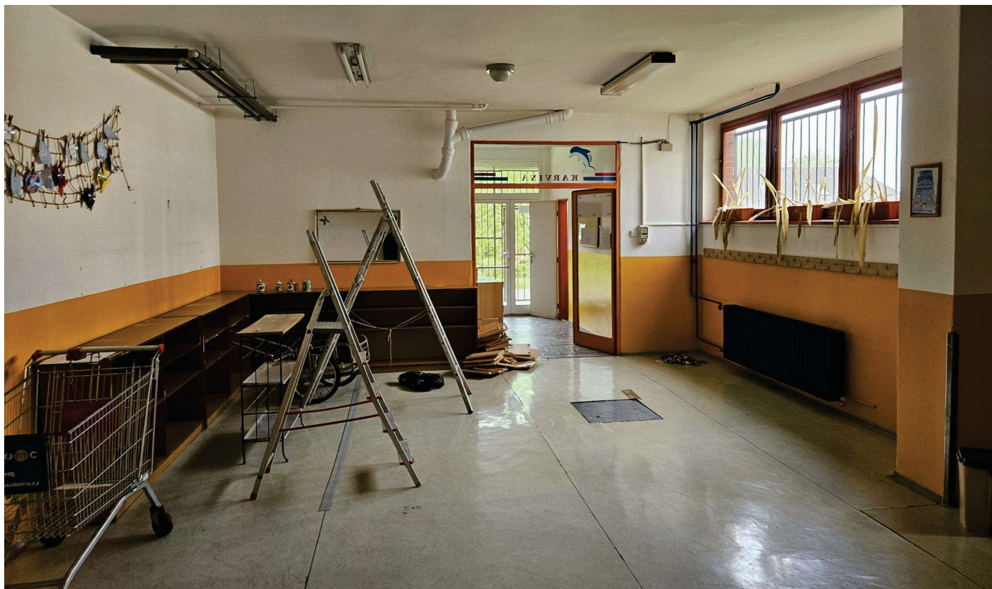
Pohled na vstupní halu a zádveř objektu
