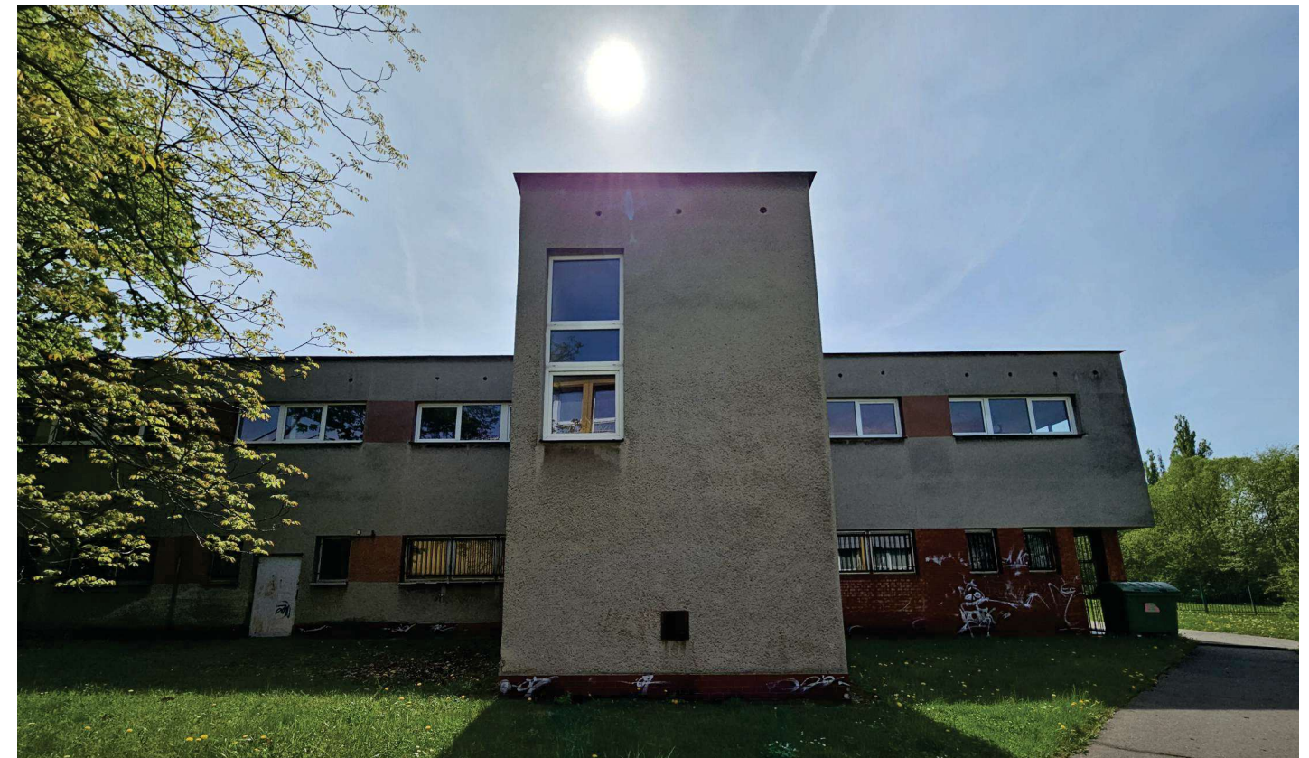
Pohled na zadní fasádu objektu
