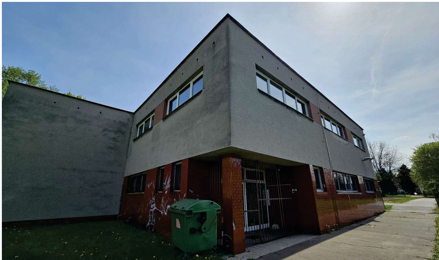
Pohled na boční fasádu objektu
