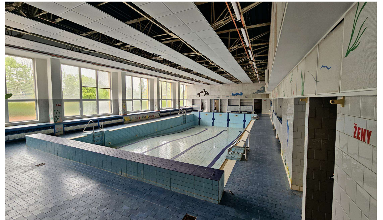
Pohled na bazénovou halu
