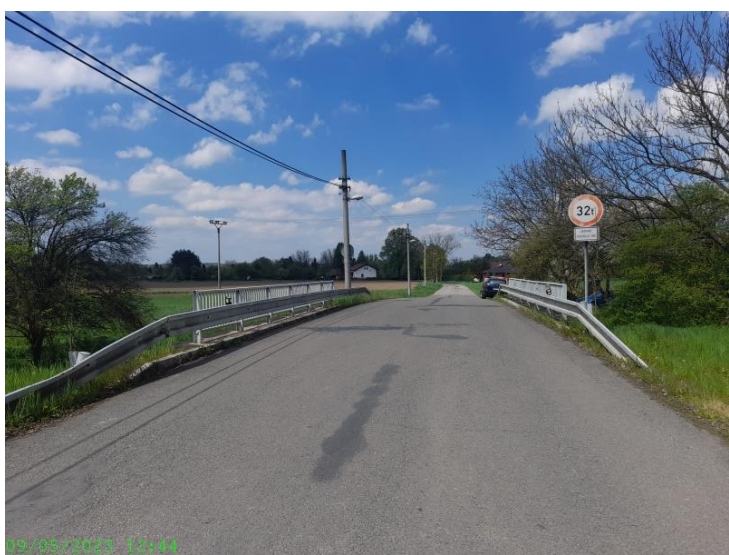
Pohled na most proti směru staničení.
