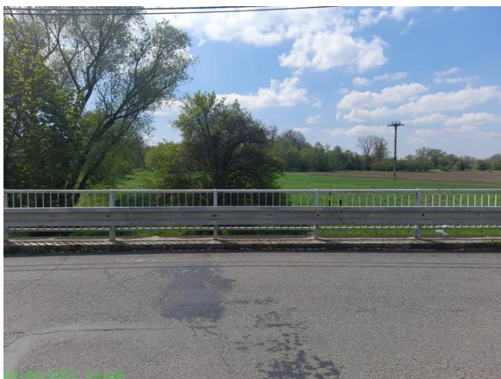
Pohled na zábradelní svodidlo pravá římsa
