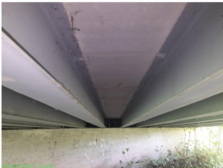
Podhled nosné konstrukce
