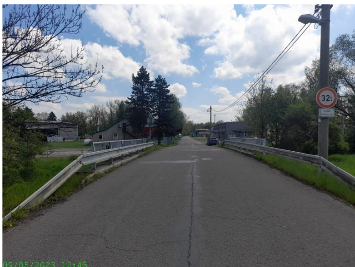
Pohled na most ve směru staničení.
