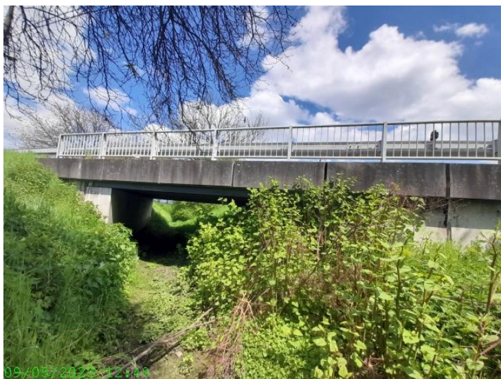
Pohled na most zprava.
