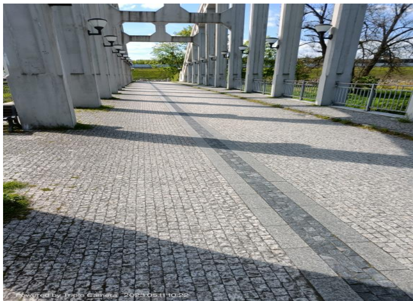
Celkový pohled na mostní vozovku od OP1.
