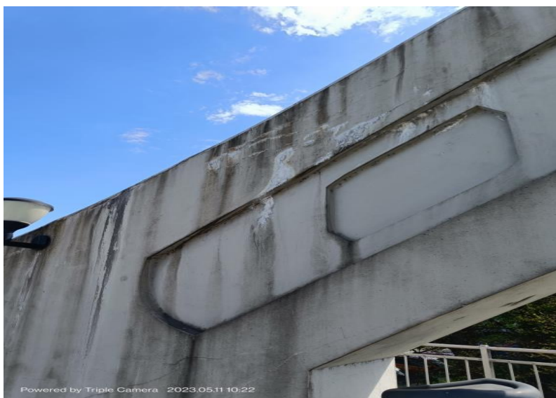
Levý oblouk, trhlínky nad prvním táhlem, OP1.
