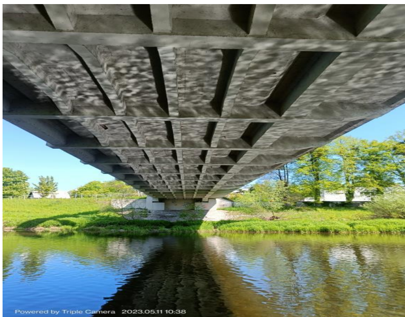
Podhled nosné konstrukce od OP2.
