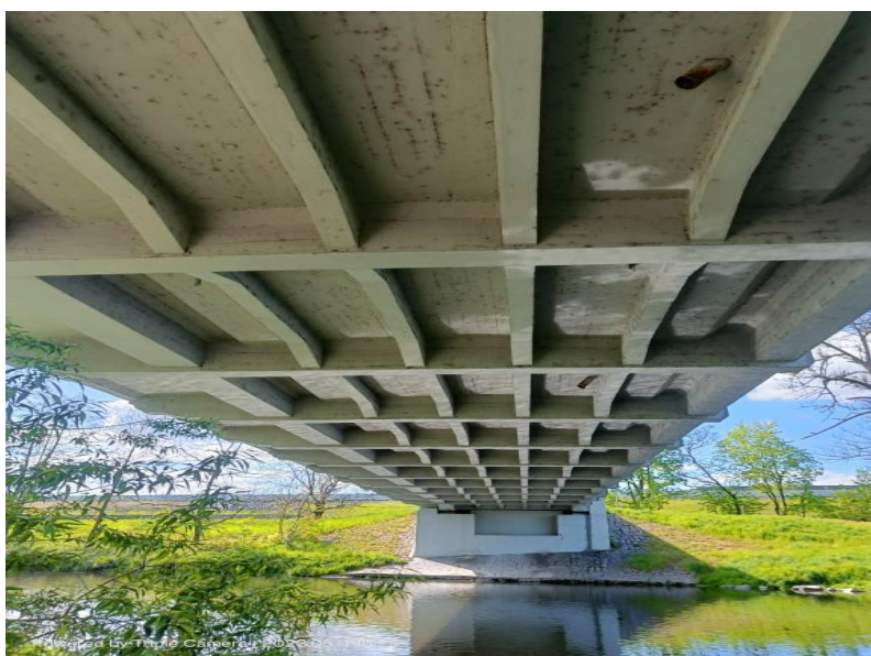
Podhled nosné konstrukce od OP1.
