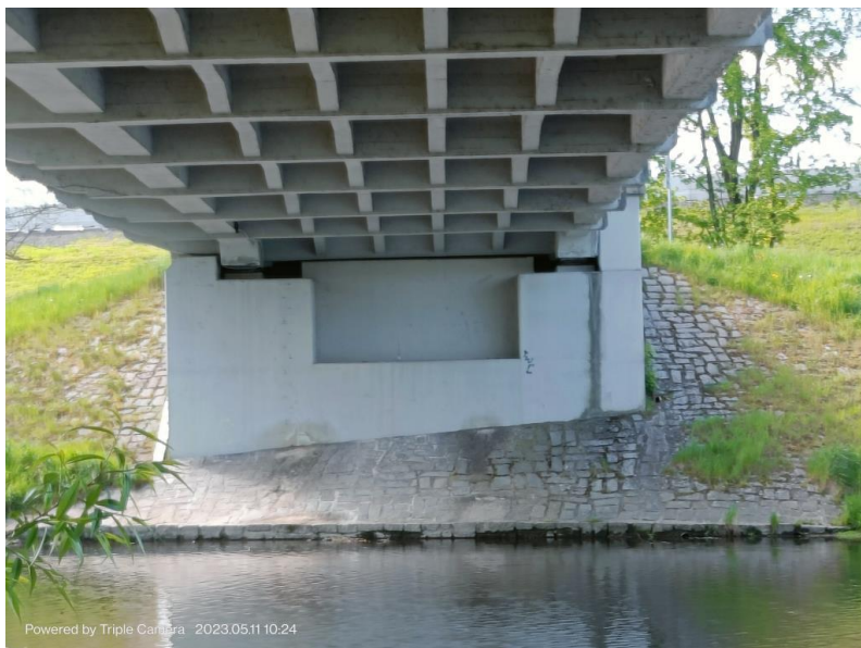
Pohled na opěru OP2.
