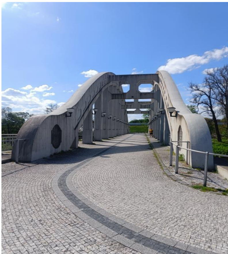
Pohled na most ve směru orientace záznamu.
