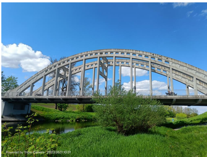
Pohled na most zleva (vtok).
