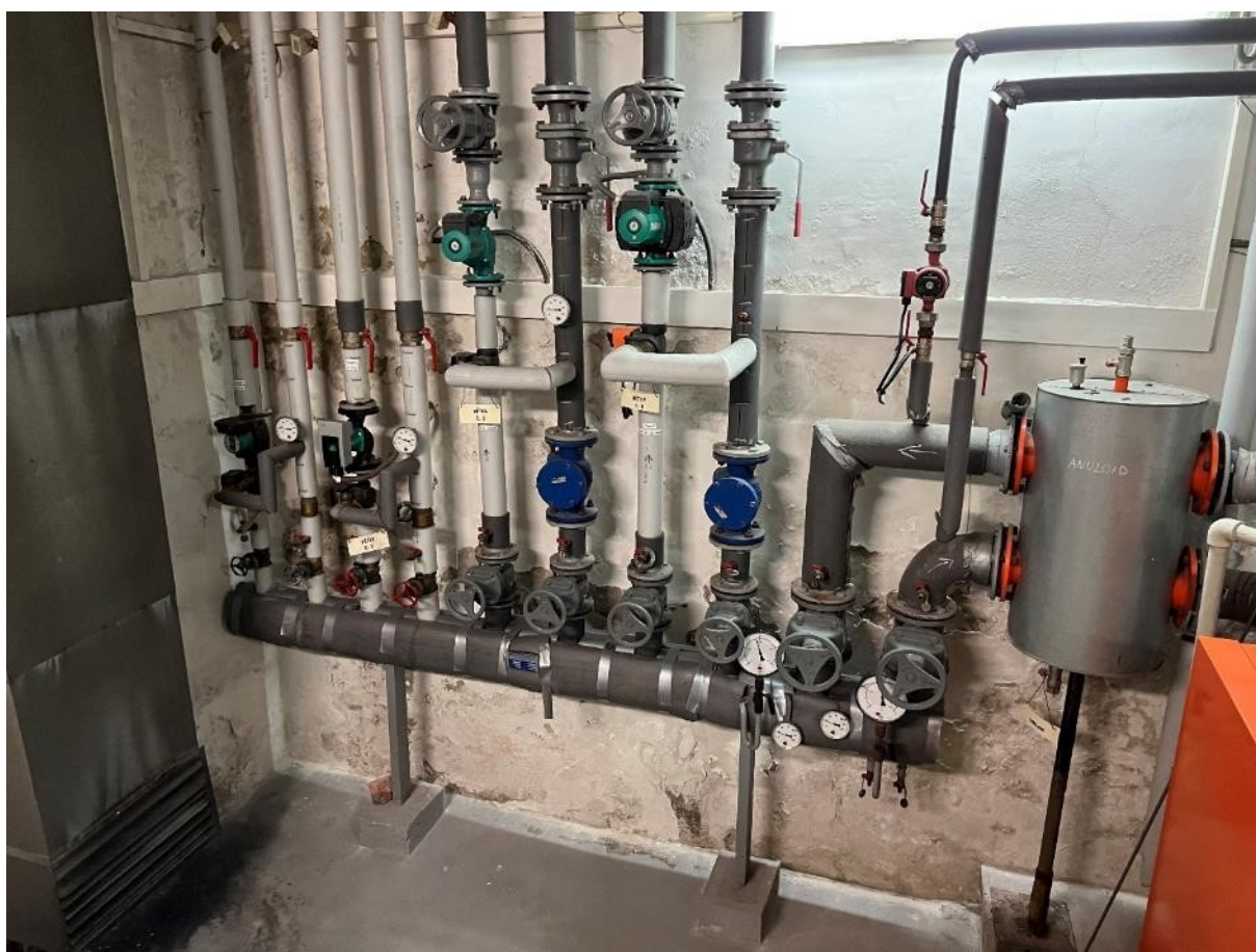
Obr. Rozdělovač / sběrač topné vody
