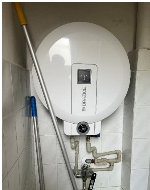
Obr. Lokální elektrické ohříváče teplé vody
