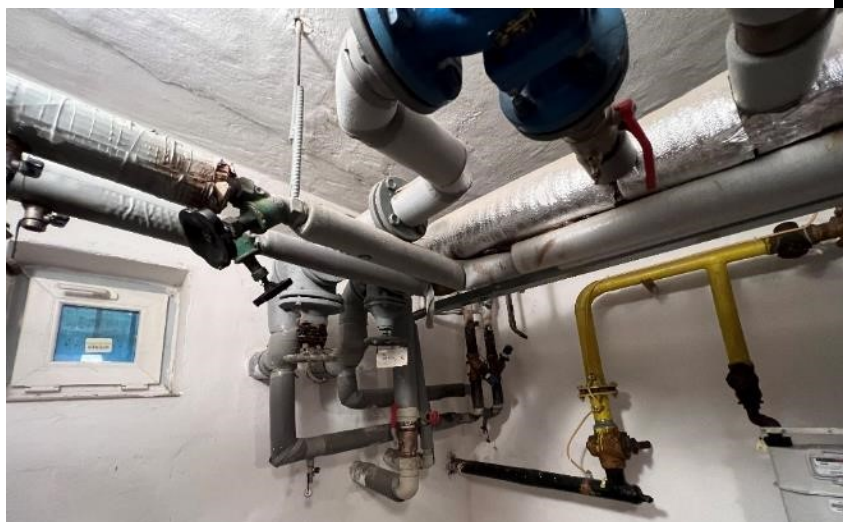
Obr. Regulační uzel pro Jídelnu a Družinu
