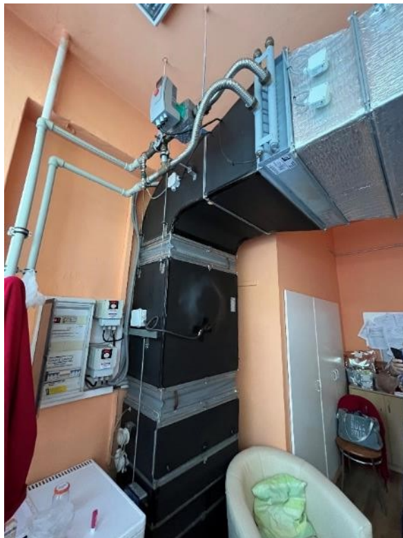
Obr. Regulační uzel pro výměník VZT
