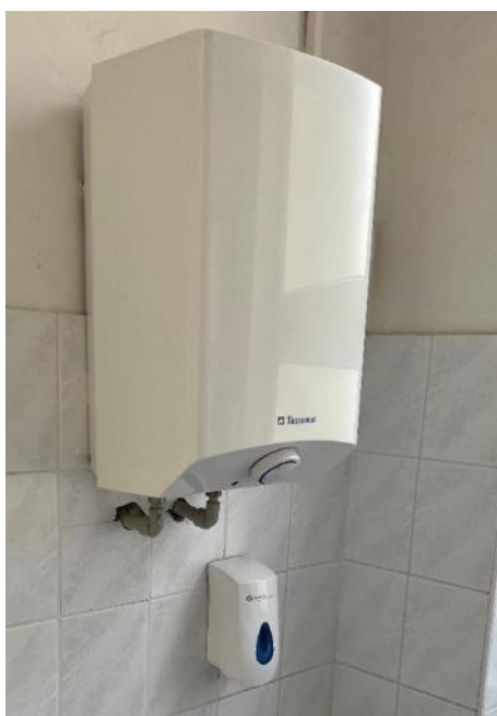
Obr. Lokální elektrické ohříváče teplé vody
