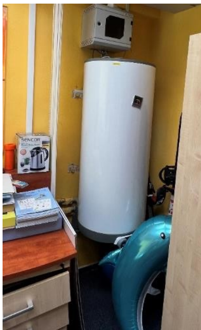
Obr. Elektrický bojler ohřevu teplé vody
