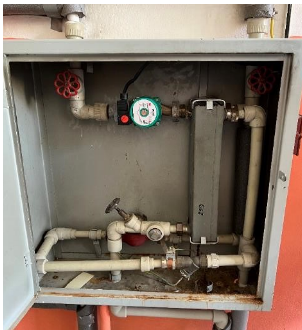
Obr. Výměník přípravy teplé vody
