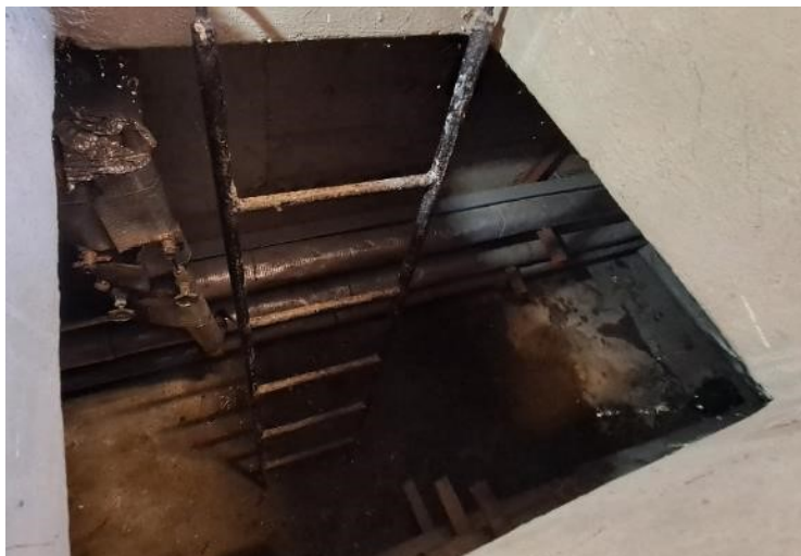
Obr. Přívod topné vody k R+S ÚT
