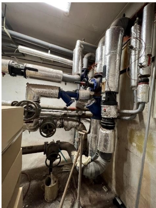
Obr. Regulační uzel ve strojovně školy
